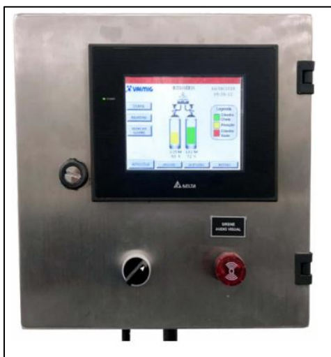
Figura 10 - Exemplo de painel de alarme operacional de uma central de cilindros.
